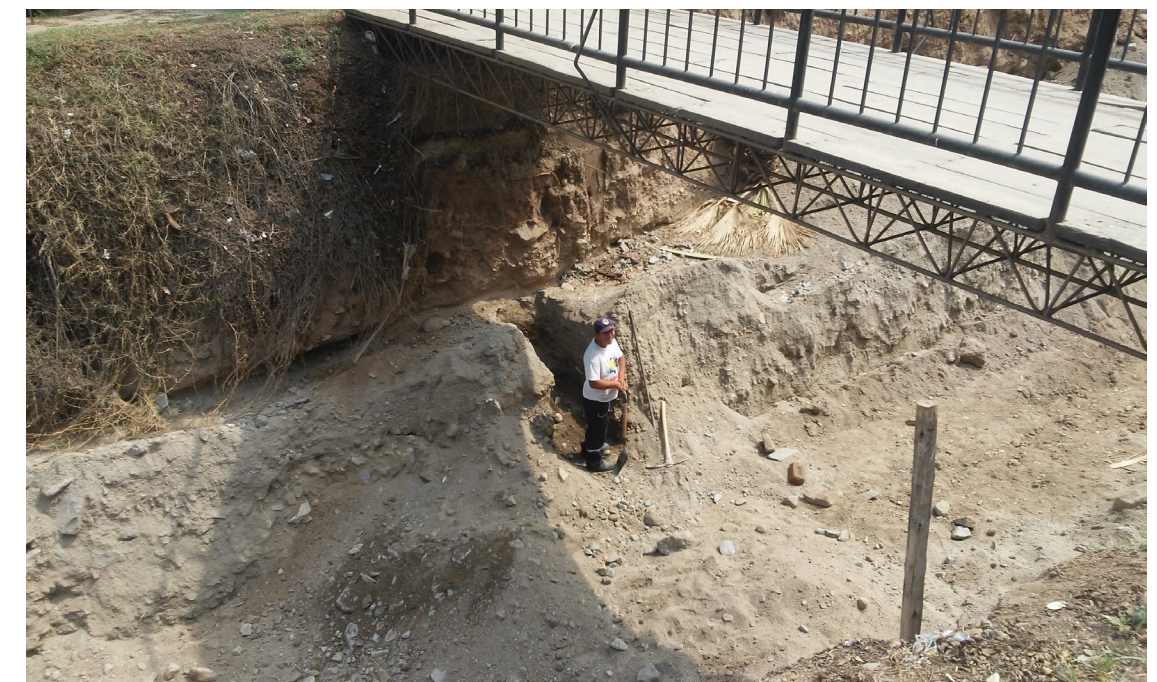
Trabajadores habilitan el puente que une la Universidad con los planteles de Educación.
